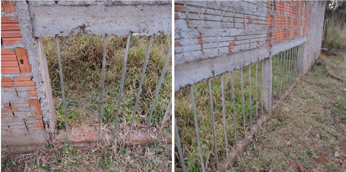
Fotos das Grades parte inferior muro – para escoamento de água pluvial
